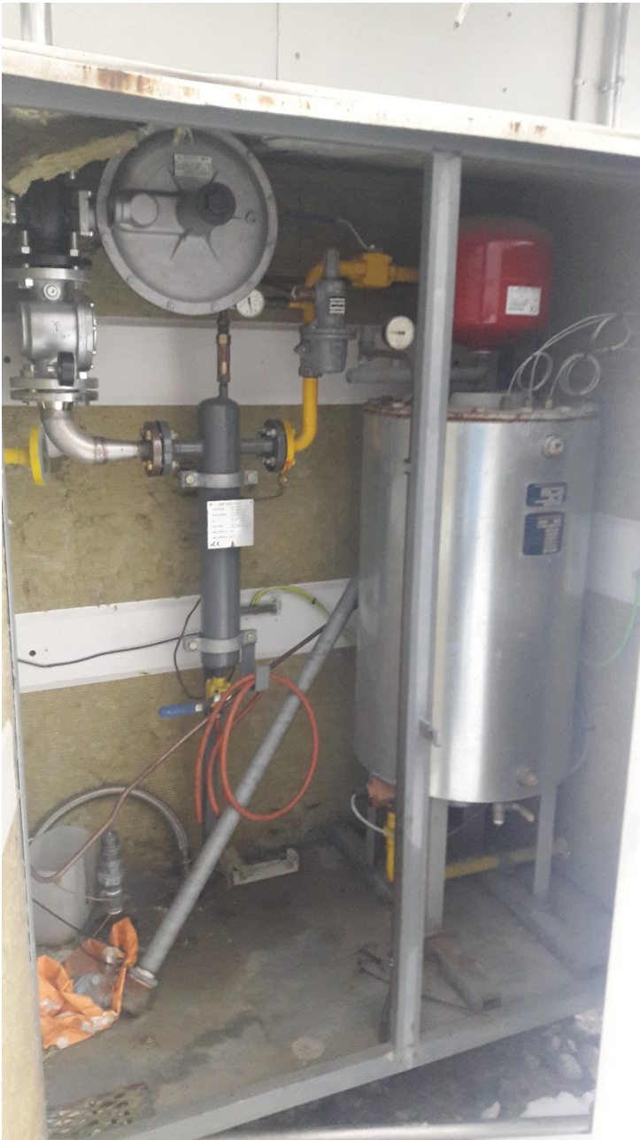
Kuva 5. Käytöstä poistettavan nestekaasusäiliön yhteydessä oleva nestekaasun höyrystyksikkö (nestekaasun höyrystys ja paineenalennin).
