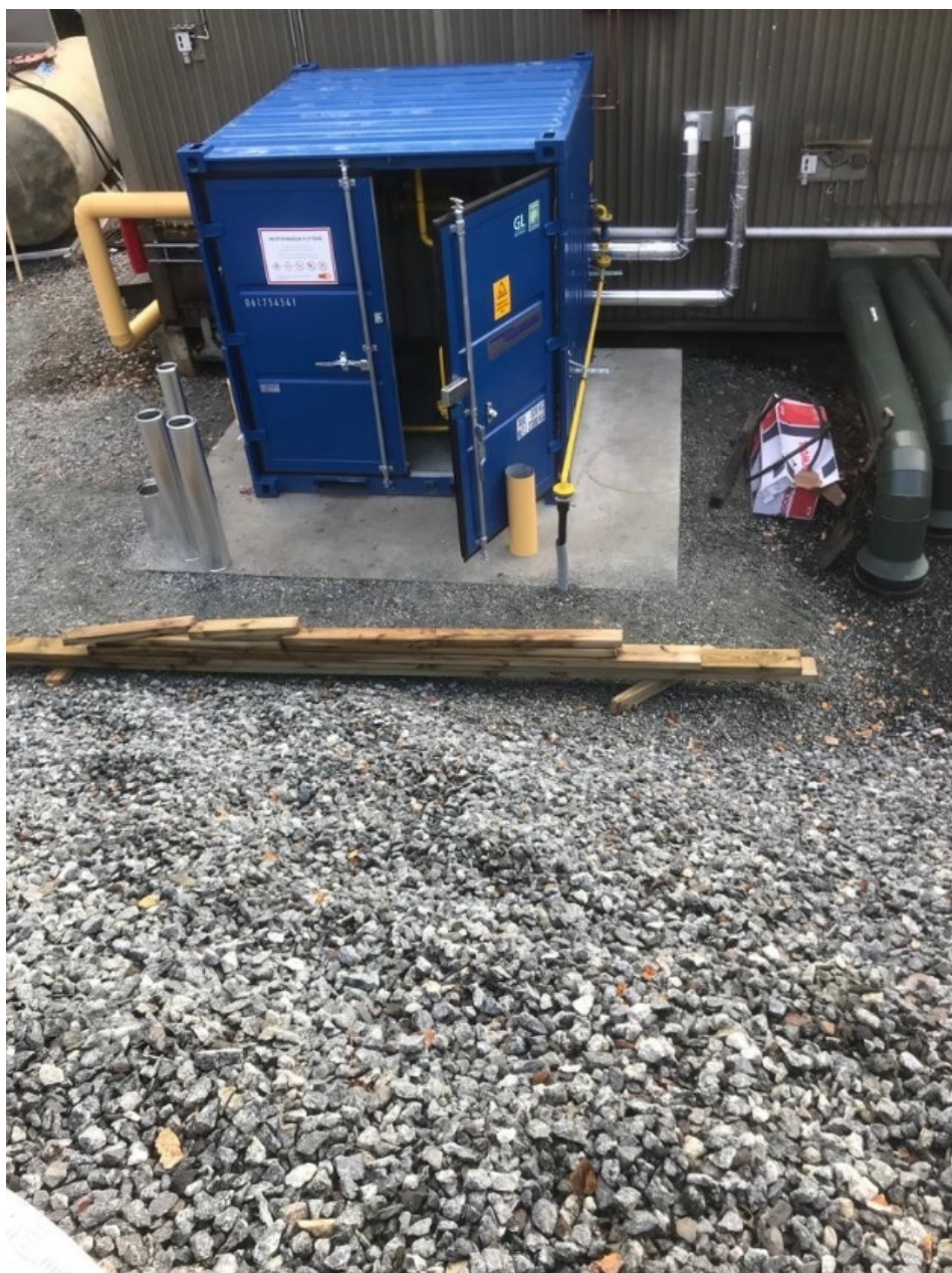
Kuva 2. Höyrystinyksikön kytkeytyminen höyryntuotantokonttiin. Kuvan mukainen ratkaisu voi pieniltä yksityiskohdiltaan poiketa Latvaenergia Oy:n höyrystimestä. Kuva: KosanGas.
