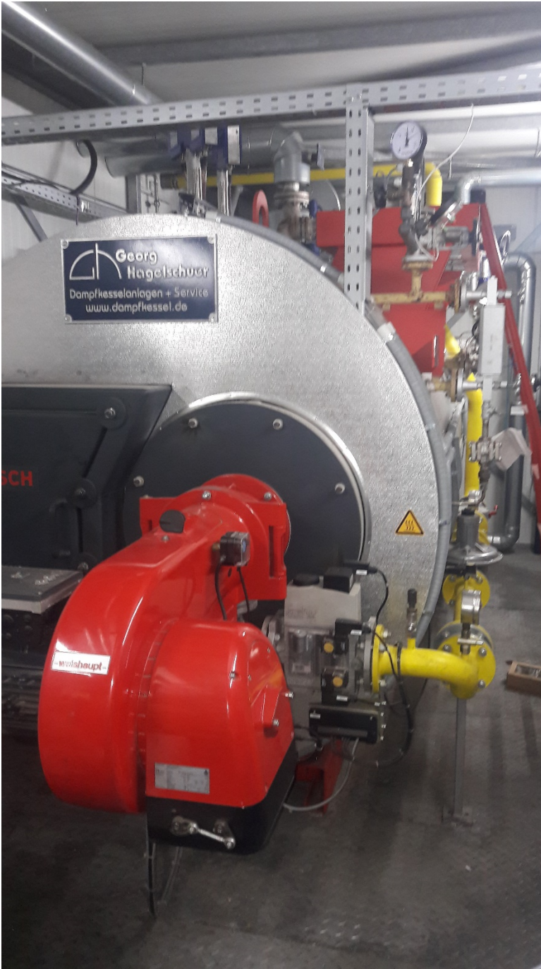
Kuva 2. 1,4 MW:n siirrettävän höyrykattilakontin poltin ja höyrytuotantokattila.
