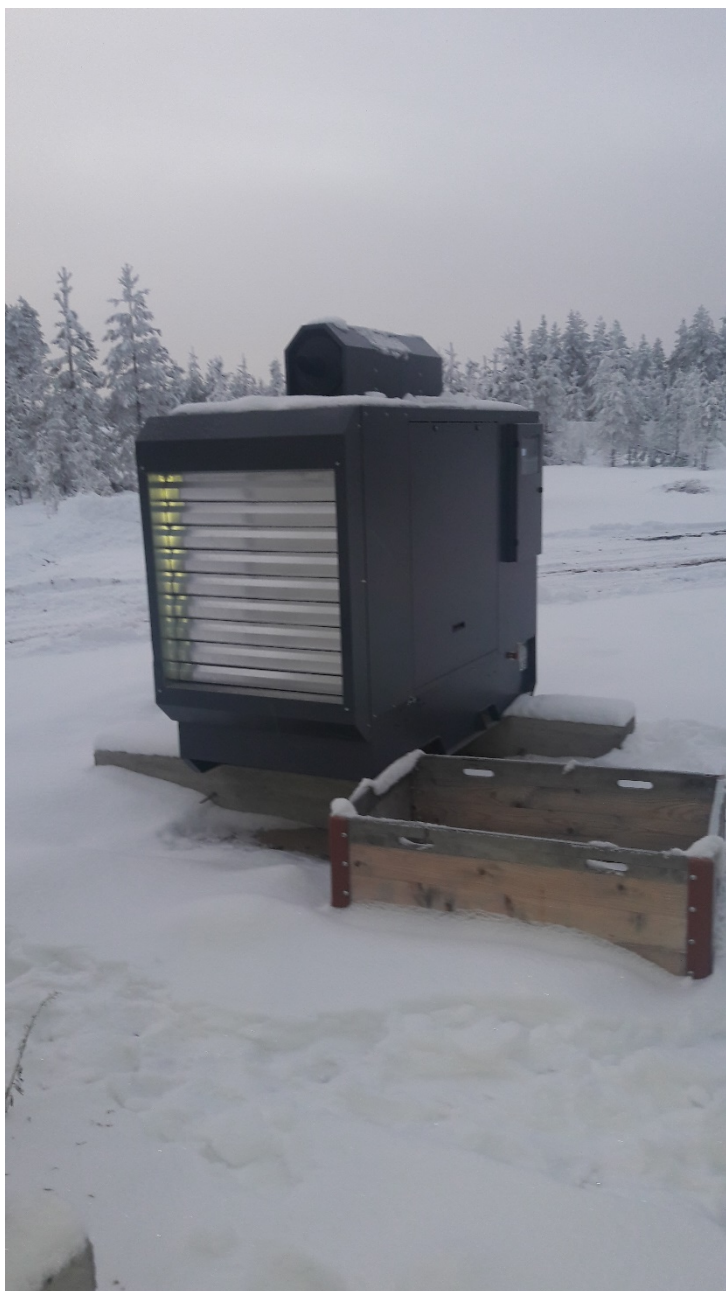
Kuva 3. Feelia Oy:n kiinteistöllä olevan höyrykontin yhteyteen sijoittuva varavoimalähde (käytössä mahdollisen sähkökatkon aikana).
