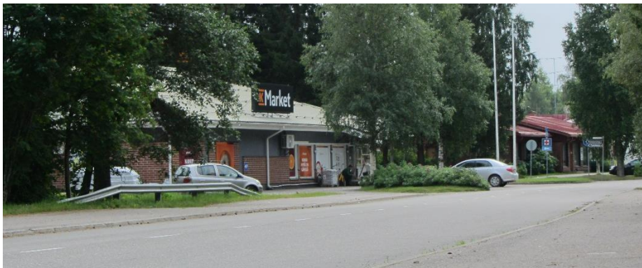
Keskustan liikerakentamista. Molemmat päivittäistavarakaupat sijaitsevat Keskustien varressa.
