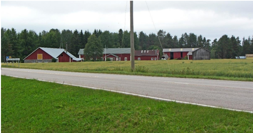
Leiviskän pihapiiri ja peltoalueet ovat maakunnallisesti arvokas rakennettu kulttuuriympäristö. Ouluntie kulkee alueen läpi ja katkaisee aluekokonaisuuden kahteen osaan.
