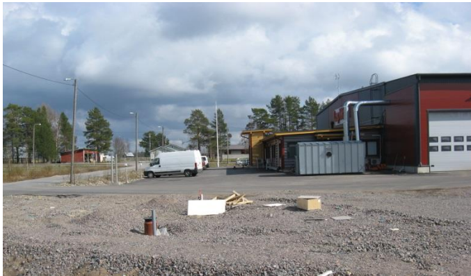
Lapwall Oy:n rakennuksia. Leiviskäntien ja Tukkitien väliin jäävällä korttelialueella (tontit 14–17) on yhteensä viisi suurta teollisuushallia ja lisäksi varastointikatoksia. Yrityksen toiminta alueella on kasvanut hyvin nopeasti.
