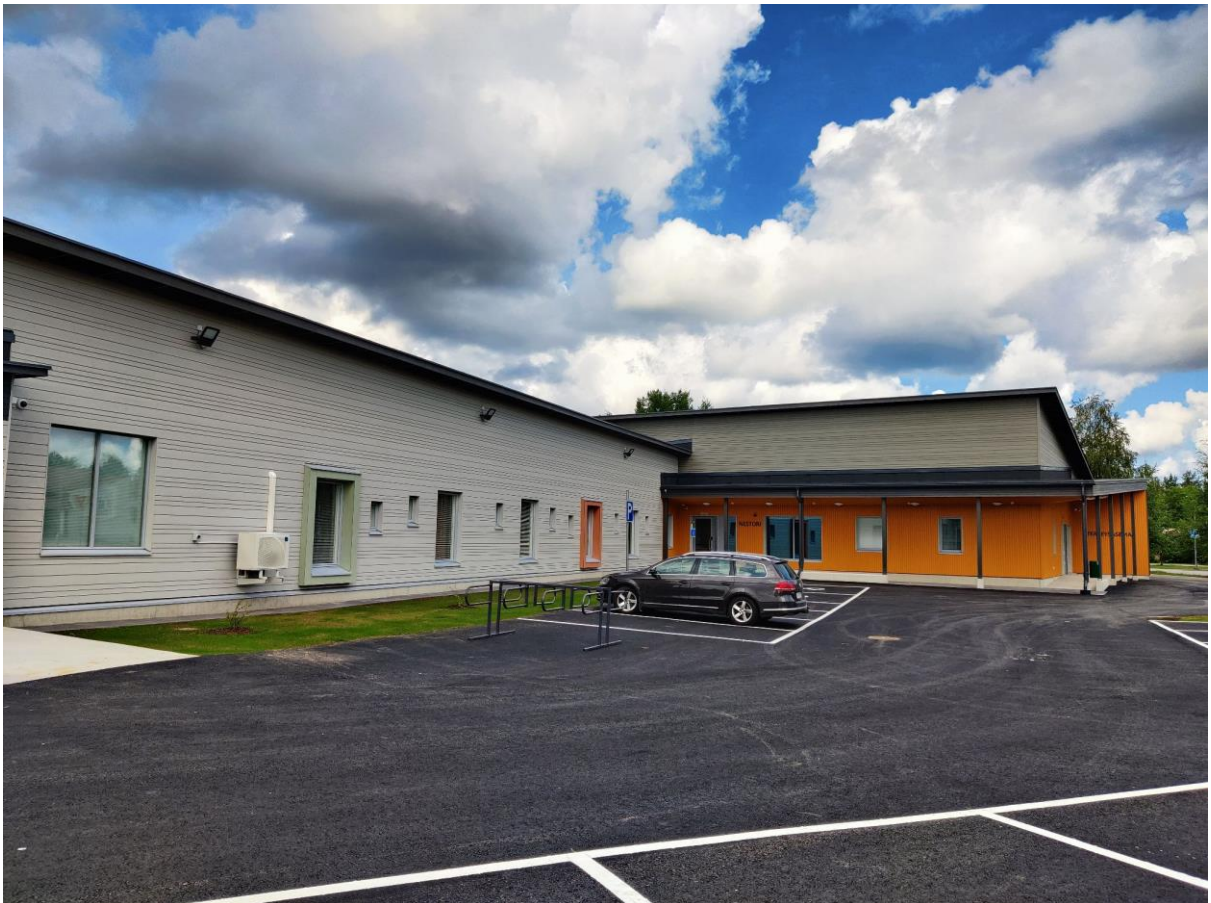
Kansikuva: Pyhännän sosiaali- ja terveyskeskus valmistui heinäkuussa 2023. Kuvannut Matti Leiviskä.
