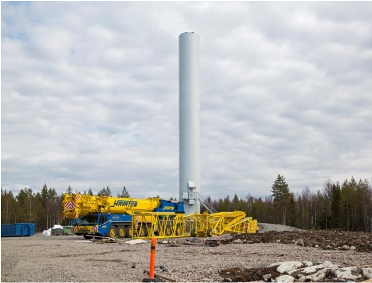
Kuva 2-20 Tuulivoimalan kokoamista. (Kuva: Ville Suorsa, FCG)
