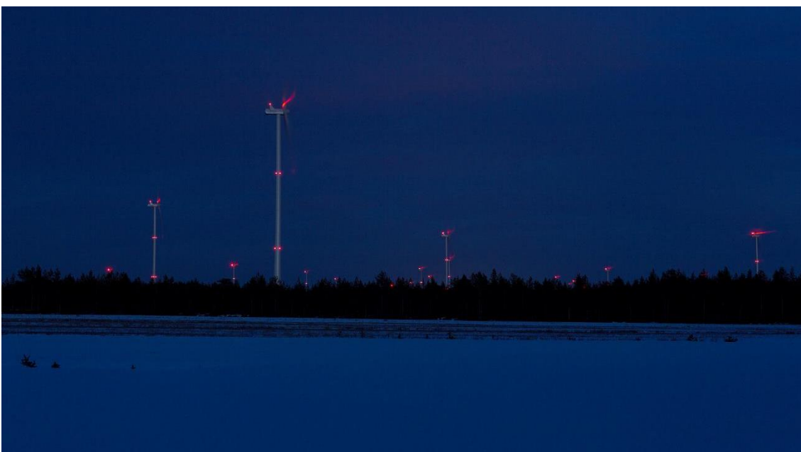
Kuva 2-13 Kiinteät punaiset lentoestevalot. (Kuva: Ville Suorsa, FCG)
