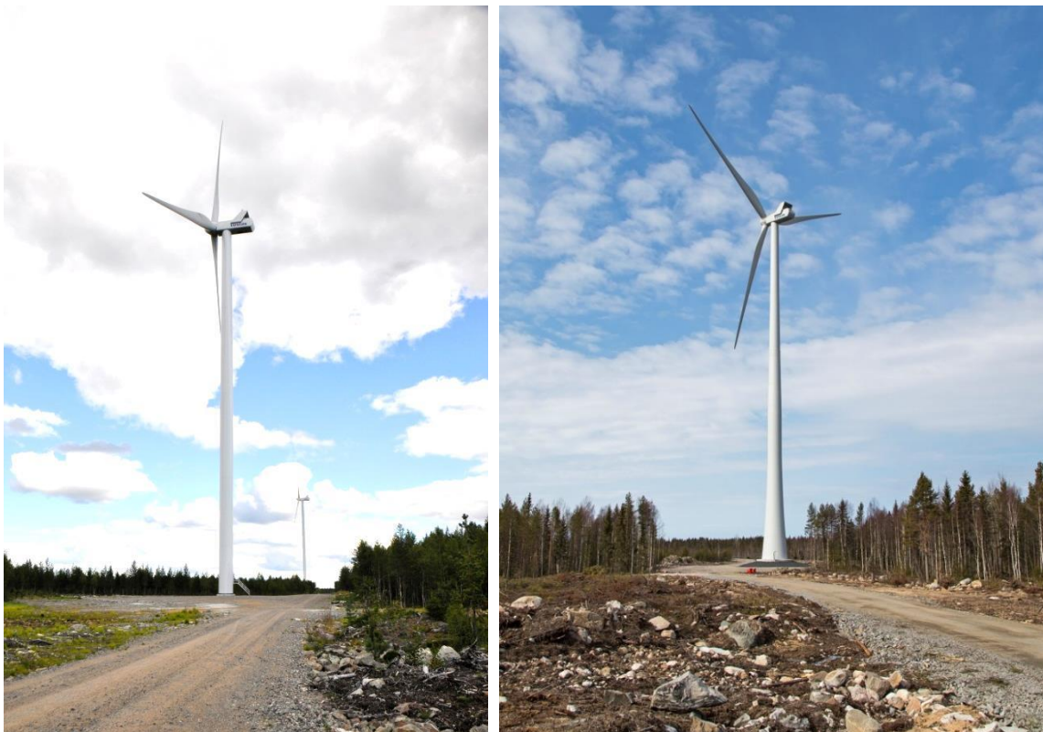
Kuvapari 2-10 Vasemmalla on esimerkki teräslieriötornista ja oikealla hybriditornista. (Kuvat: Leila Väyrynen ja Ville Suorsa, FCG)
